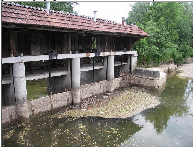
Slika 3: prvotni jez na Cerknjščici s serijo zapornic (levo) in novi mehki jez (desno)
