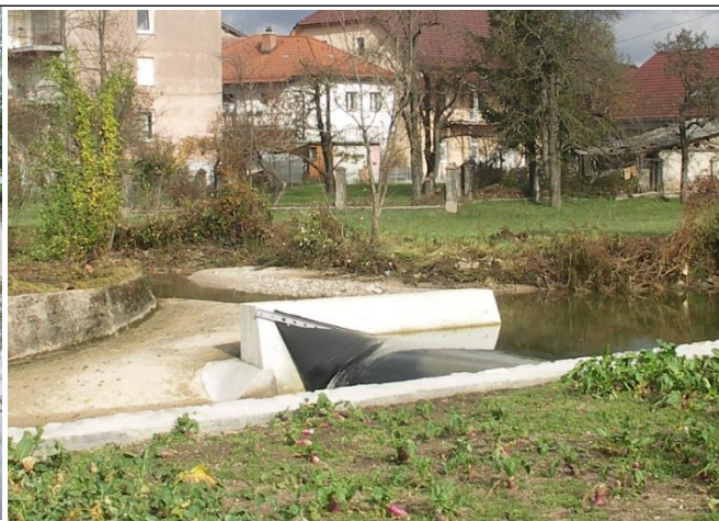
Slika 3: prvotni jez na Cerknjščici s serijo zapornic (levo) in novi mehki jez (desno)
