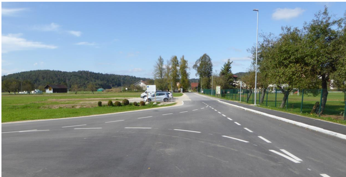
slika 1: pogled iz že rekonstruiranega območja priključka na R1-212/1118 (profil N5) v smeri za dokončanje rekonstrukcije predvidenega odseka Notranjske ceste (profil N1)
