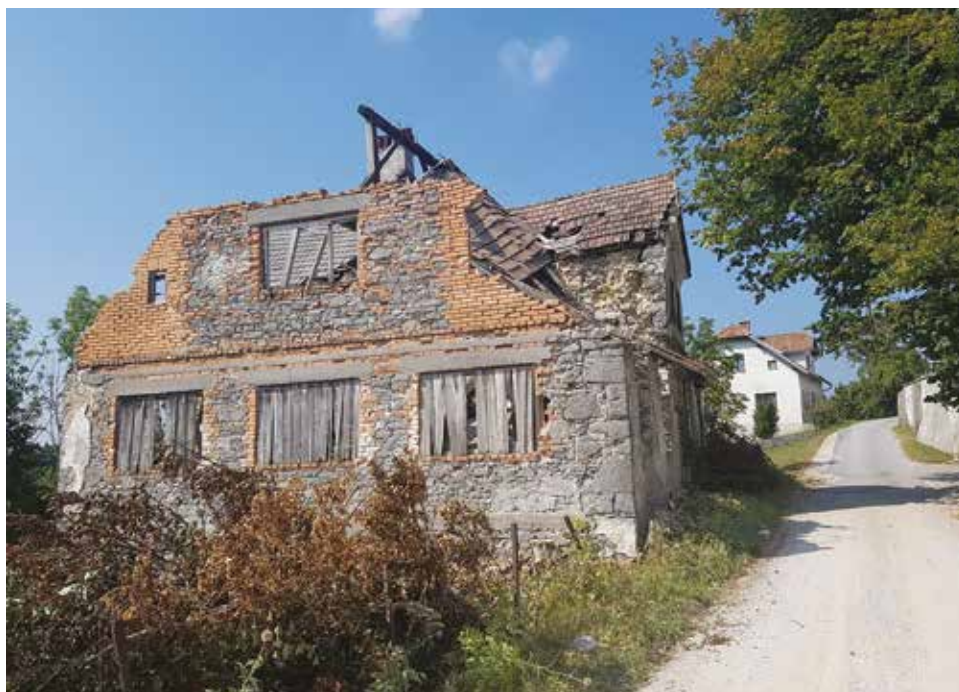
Zapuščena vidovska šola pred rušitvijo 2018 (© Peter Frece)
