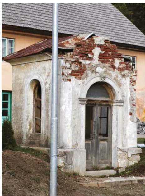
Propadajoča kapelica pred obnovo (© Matjaž Žnidaršič)
